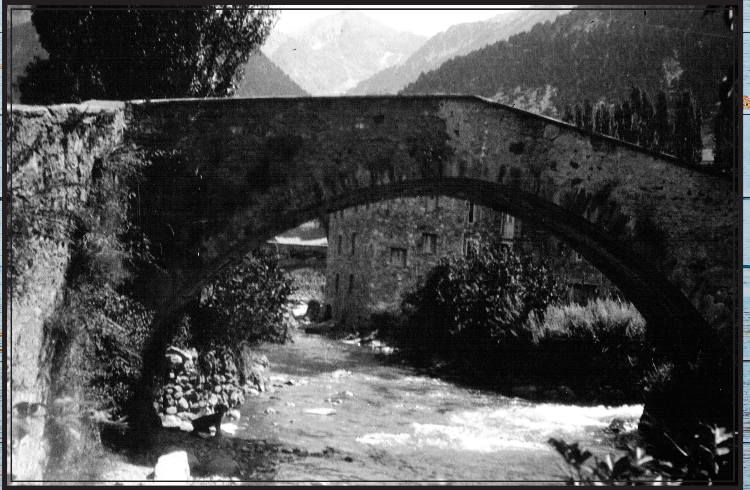
Puente sobre el río Aguaslimpías en Sallent de Gállego
